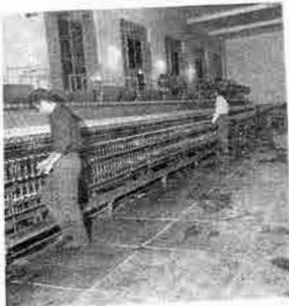
قسمتی از ماشین آلات ریسندگی کارخانه پشمیافی شرق
